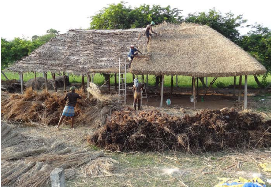
De veestal krijgt een nieuw rieten dak.
